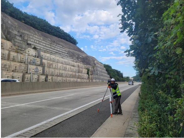
광파기를 이용한 측량 작업사진
